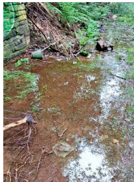
Zugesetzte Entwässerungs- anlage durch abgelagerten Grünschnitt ➔
