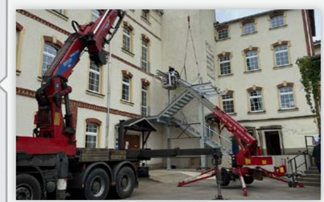
Im **Juli 2024** wurde die brandschutztechnische Sanierung der Böttcherfabrik in Pobershau abgeschlossen. Es wurden Brandschutzwände inklusive Brandschutztüren sowie eine Fluchttreppe errichtet. Nach einer 10-monatigen Schließzeit konnte die Einrichtung damit endlich wieder für den Besucherverkehr geöffnet werden.
