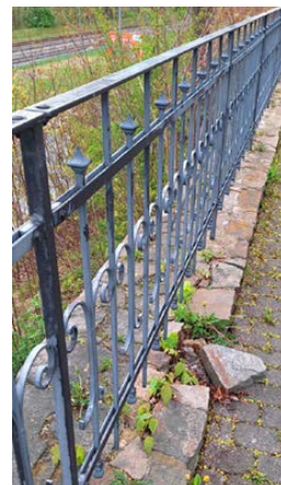
Schadhafte Mauer
