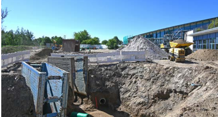
Umverlegung der Abwasserleitung
