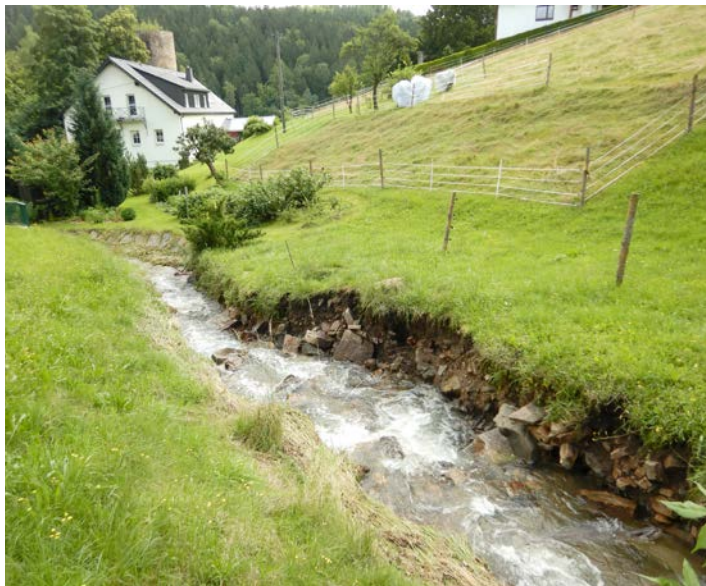
Böschungsabbruch im Bereich des Hundsbaches/Niederlauterstein unmittelbar nach dem Starkregen
