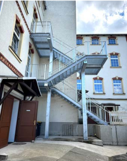
Anbau der Fluchttreppe am Gebäude Böttcherfabrik.
