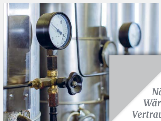
Manometer im EVM-Heizwerk zeigen den Druck des Heizwassers in den Rohren an.
